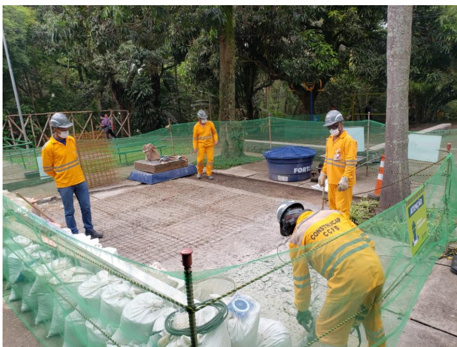
Figura 26: Manutenção no piso do parque
